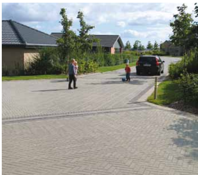
Med et smalt tværprofil, ingen fortove og ingen lange lige stræk, kombineret med skift i belægningen holdes farten nede.
