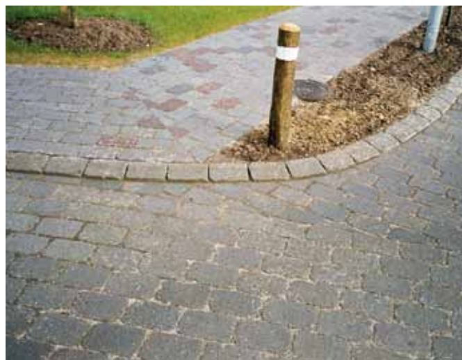
I denne belægning har der været gravet op for at reparere telekabler.
