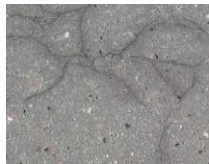
Eksempel på alkalikiselreaktioner, også kaldet "spindelvæv".
