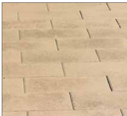
Lader man fugegrus henligge på belægningen, risikerer man afsmitninger, der i værste fald bliver bundet af kalkudfældninger.
